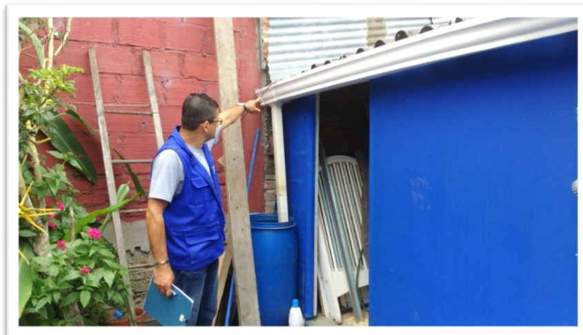
Tanque de reciclaje de aguas lluvias
