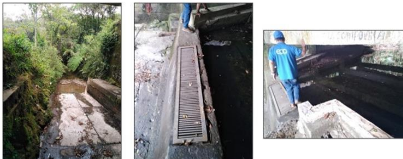
Imagen 3: Bocatoma La Marina. Fuente: Propia
