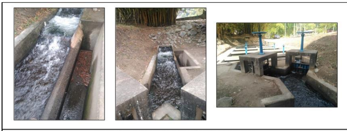
Ilustración 3 Desarenador La Marina, cámara de llegada
