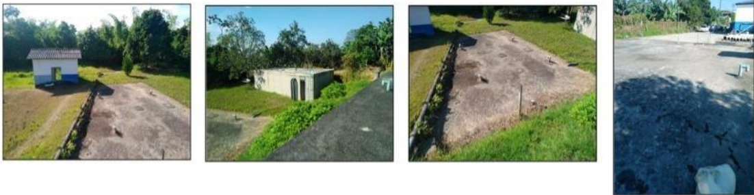
Imagen 10: Tanques de almacenamiento. Fuente: Propia
