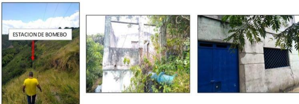
Imagen 8: Estación de bombeo. Fuente: Propia
