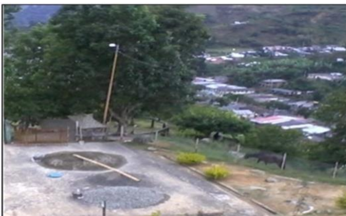
Imagen 9: Tanque de almacenamiento. Fuente: Propia
