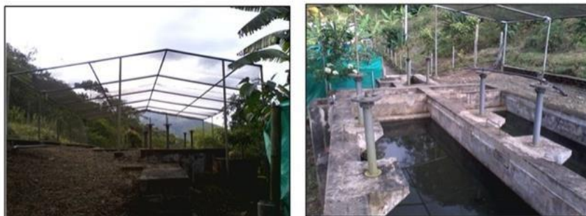
Imagen 6: Desarenador Arenas. Fuente: Propia
