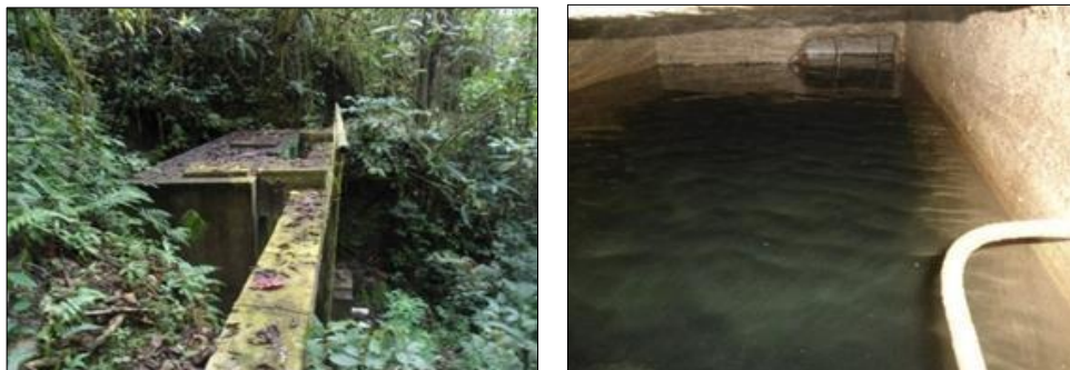
Imagen 7: Desarenador La Calzada. Fuente: Propia
